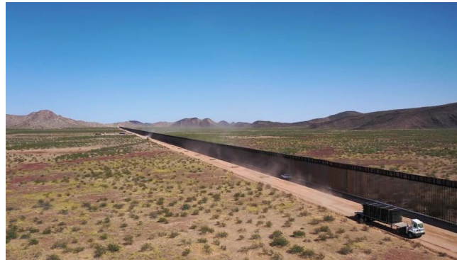
Figura 6. Nuevo muro fronterizo construido en el Parque Nacional El Pinacate/Cabeza Prieta. Crédito de la foto: Russ McSpadden/Centro para la Diversidad Biológica
